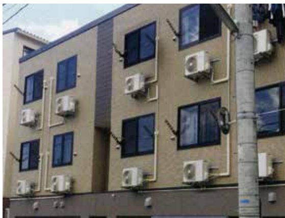
生活支援ハウス 名島シーサイド 外観
